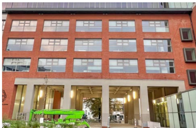
Binnenvest Den Bell. Onder de dakgoot zijn de nestkasten aangebracht (foto: Johan Kempeneers)
