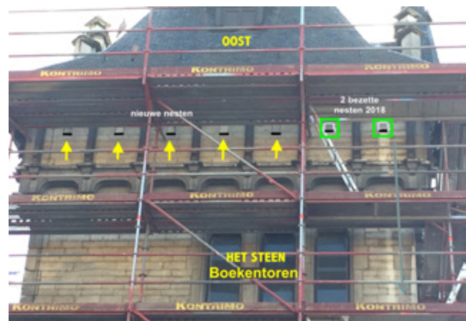
Steigeraten in de Boekentoren van het Steen (foto: Johan Kempeneers)
