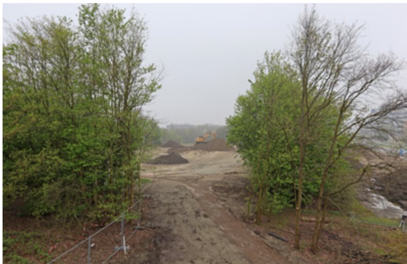
Graafwerken aan de ingang van Wolvenberg Natuurpark (foto: Erik Molenaar)
